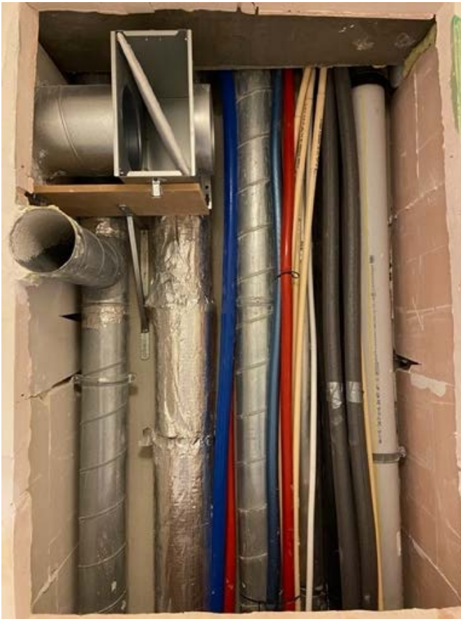
Schachtopening achter het toilet, voordat de ventilator werd geplaatst. De filterkast en de pijp naar de woonkamer zijn wel te zien.
